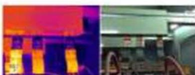
Búsqueda de puntos calientes en los distintos elementos de la instalación, que puedan suponer un riesgo de cara al normal funcionamiento de la instalación.
