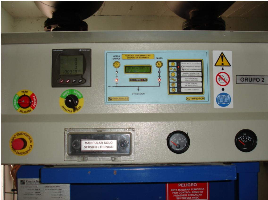
El equipo de control automático del grupo electrógeno tiene la función de efectuar el arranque y sincronización del mismo con los demás grupos al recibir una señal del exterior. Además se encargará de proteger al grupo de las anomalías más importantes que podrían dañarlo en su funcionamiento. Dispone de los diversos elementos de mando sobre el grupo para los diversos modos de funcionamiento, pruebas, alarmas, potenciómetros de ajuste, disyuntor general de grupo, etc.
