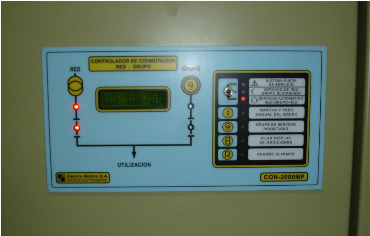
El cuadro automático de cada grupo arranca y sincroniza el grupo eléctrico al recibir una señal del exterior, y lo para al retirarse la señal. La instalación necesita además de un equipo de control de conmutación y un conmutador de potencia red – grupo.
